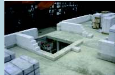
Die Steinpaletten werden auf der Baustelle sinnvoll verteilt um sich lange Wege zu sparen.
