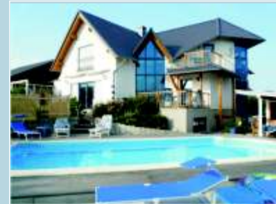
Das erste Haus, welches komplett vom Keller bis zum Dachgeschoss ohne Mörtel und Kleber in Eigenleistung erstellt wurde.
