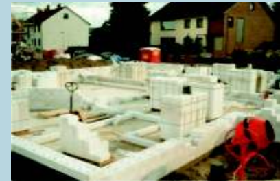
Sobald die erste Steinreihe den Grundriss Ihres Hauses bildet, können Sie mit Hand anlegen. Sie werden schnell merken wie einfach und zügig das Bauen mit diesen Steinen geht.
