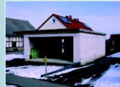
Geschlossene Doppelgarage mit Holzdach und einer separaten Eingangstür. Mauerwerksbau in Eigenleistung.
