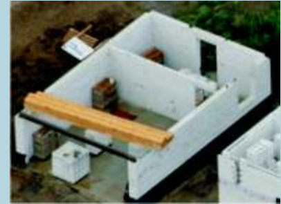
Geschlossene Doppelgarage mit Holzdach und einer separaten Eingangstür. Mauerwerksbau in Eigenleistung.
